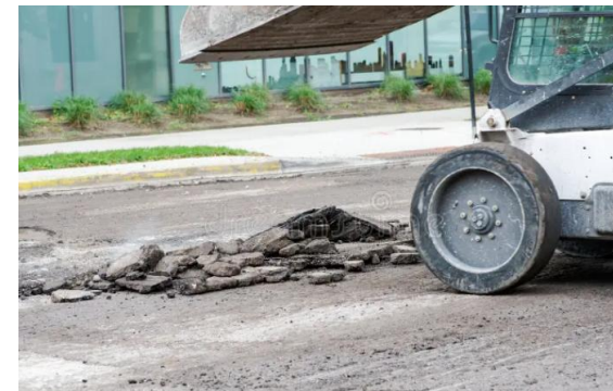
Demolizione Pavimentazione
