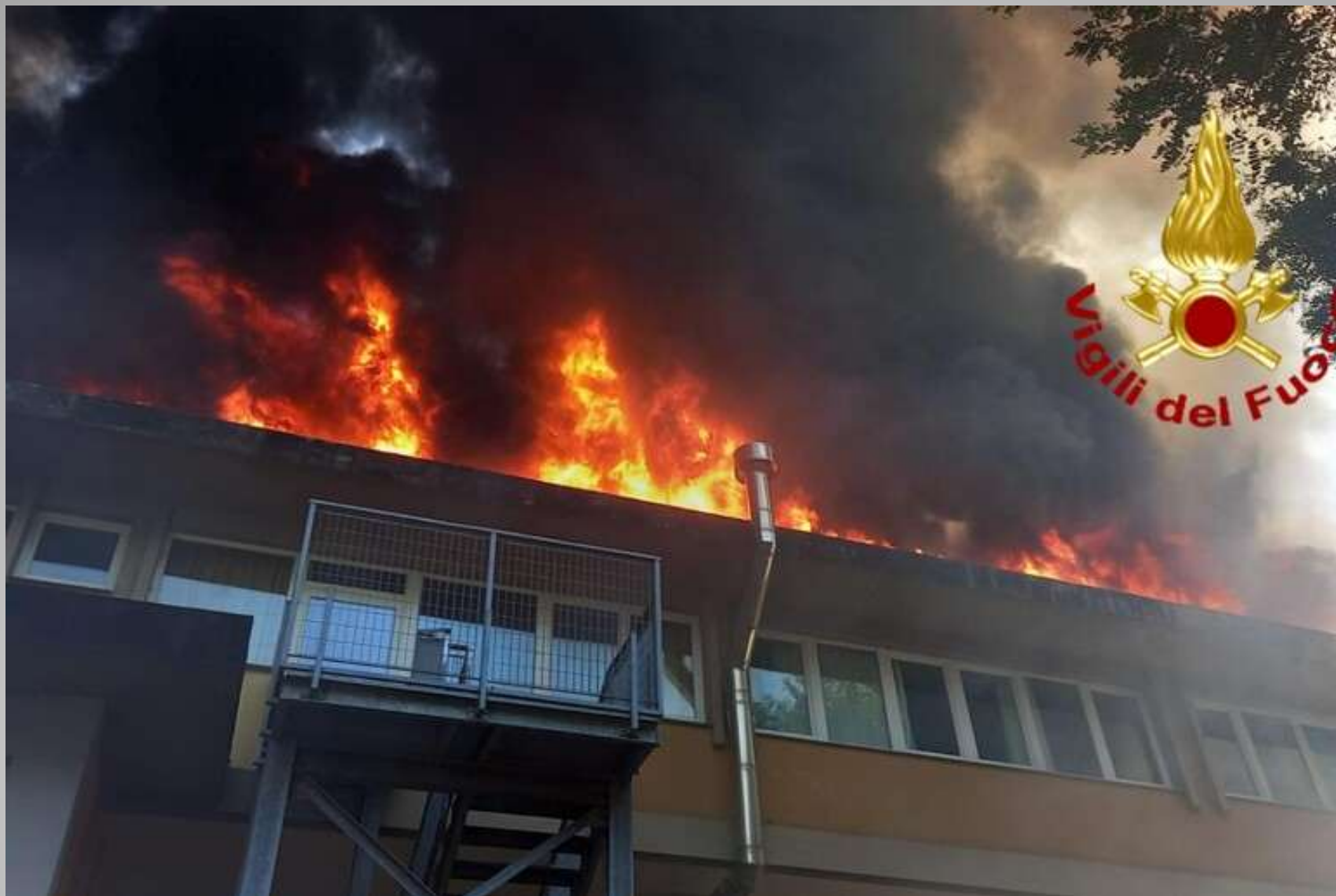
Mignanego incendio del tetto di una scuola di via Visegni
