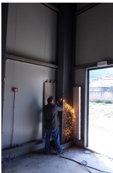
Figura 3a – Prelievo in opera di un saggio di carpenteria metallica.
