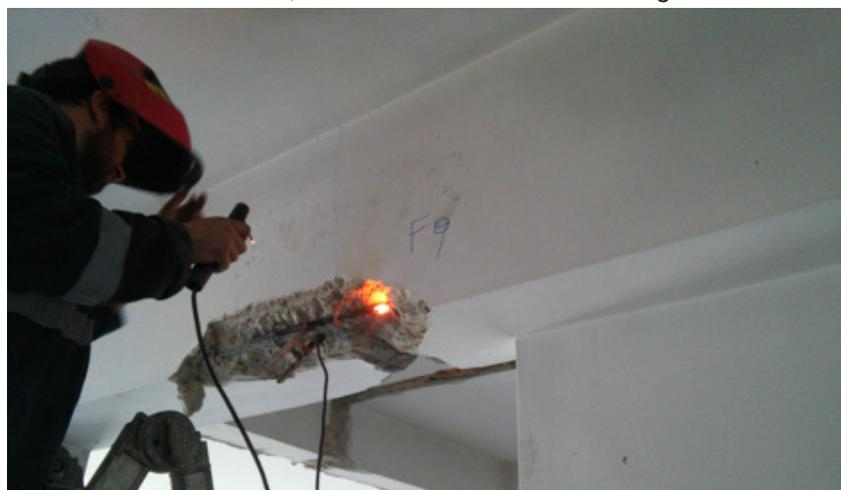
Figura 1 – Ripristino di barre d'armatura mediante saldatura
