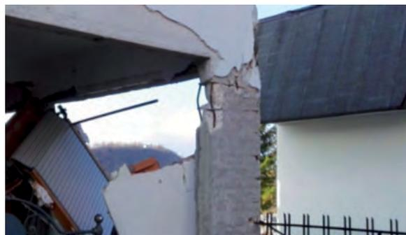
*Rottura a taglio di un pilastro d'angolo*
