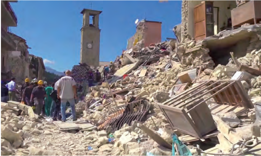
I danni del terremoto di Amatrice
