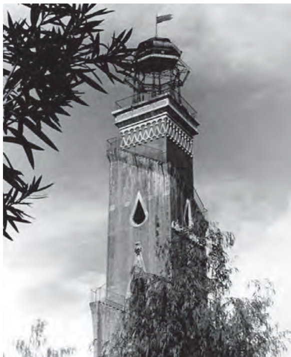
La Torre Alessi non ancora demolita
