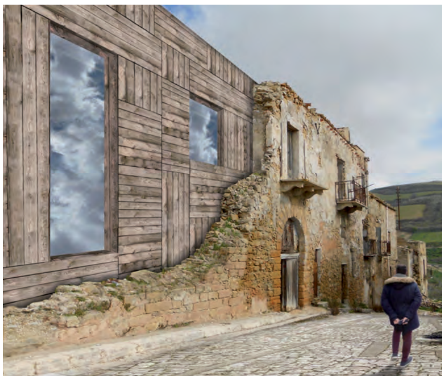
Fig. 3: Edificio per la residenza - Vista dopo l'intervento
