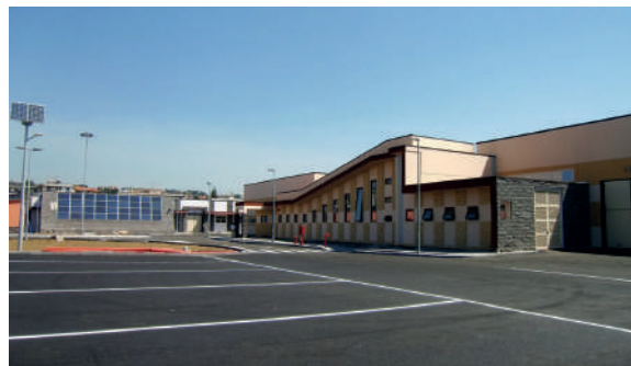
Fig. 1 - Nuovi locali adibiti a laboratori del DICAr presso il Polo Tecnologico di via S. Sofia, 102 a Catania.
