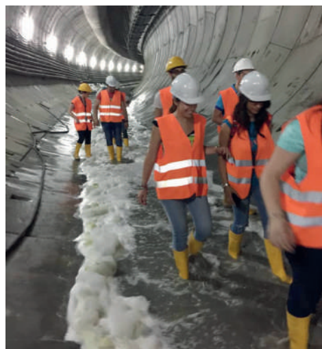
Visita tecnica al Cantiere della Metropolitana di Catania
